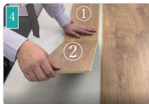
プラスチックが付いていない側の フロアを持ち上げて
