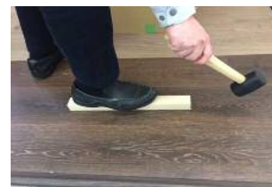
木材を軽く踏み、ハンマーにて木材を叩いてフロアを動かす。
