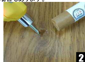
電熱コテ(ホットナイフ)にてクレヨンを溶かし、補修部分に盛っていきます。
