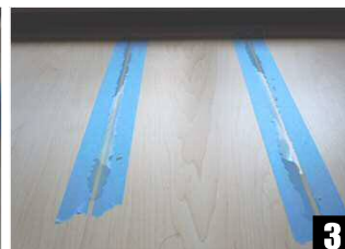
床鳴り防止剤を塗布した後、しばらく放置し乾くまで待ちます。
