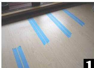
床鳴りする箇所にマスキングテープを貼ります。
