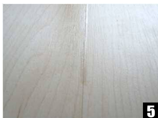
マスキングテープを剥がした後は、薬剤が残っておりますので、拭き取ってください。
