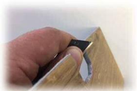
フロアを加工する場合は、剪定ばさみなどで実際のカットラインより少し内側を切り、カッターで微調整しながら加工してください。
