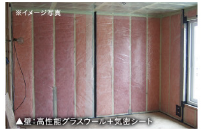
▲壁:高性能ガラスワールド気密シート
