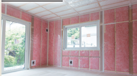
高气密・高断熱住宅を熟知した専門の職人が施工
