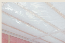
天井にもグラスウールを吹込み
