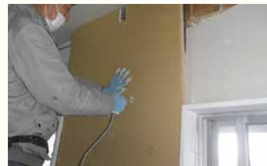
壁の断熱リフォームの様子。断熱ボードを張り、断熱性を向上
